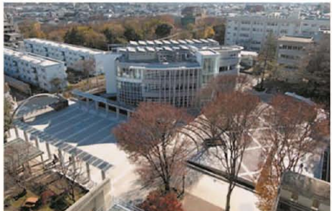
東小金井駅方面からのエントランスとなる東門と140周年記念会館エリプス
